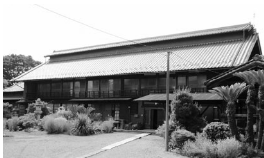
瓦屋根に換気設備(越屋根)を取り付けた近代養蚕農家の原型 田島弥平旧宅。群馬県伊勢崎市境島村地区 (写真協力:群馬県企画部世界遺産推進課)
