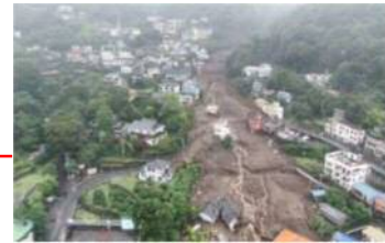
令和3年(2021)7月1日からの大雨 による土砂災害(静岡県熱海市伊豆山) 出典:国土交通省「令和3年7月1日 からの大雨による土砂災害発生状況」
