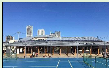
雑司が谷公園丘の上テラスの太陽光パネル
