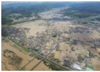
平成30年(2018)7月豪雨(西日本) (高梁川水系小田川の氾濫) 出典:国土交通省「水害レポート2018」
