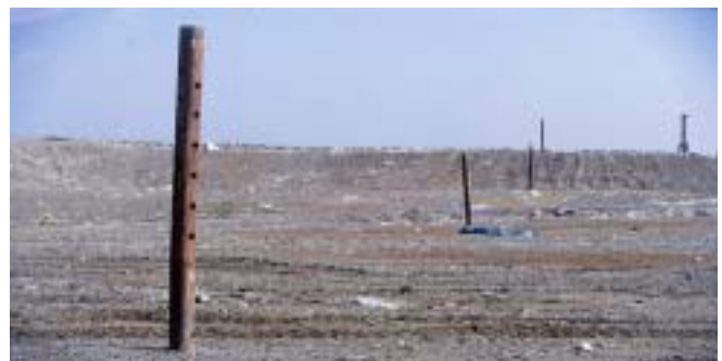
【メタンガスの発生】
