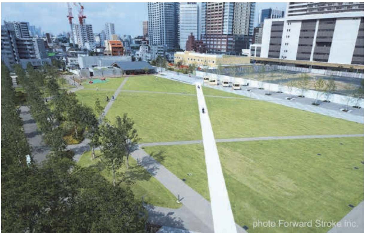
図表2-1-28 完成全景写真（としまみどりの防災公園・としまキッズパーク）
