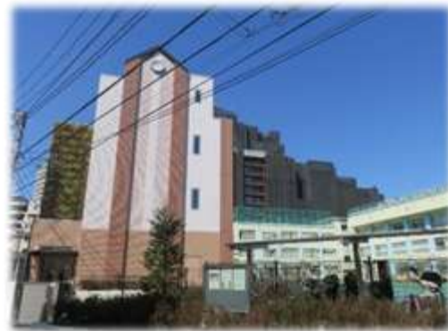
高南小学校別棟 新築工事（高田2-1-2-7）
