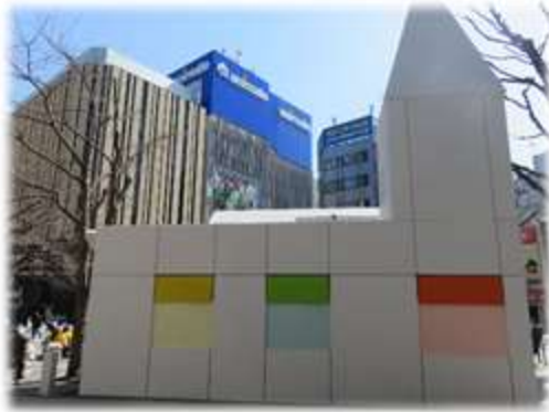
中池袋公園トイレ（東池袋4-42）
