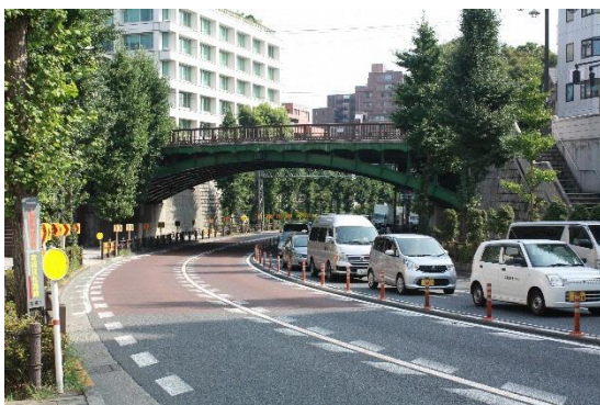
橋りょうなどの立体的かつ大規模な施設は、景観において目立つ存在であり、視点によって地模様にも地域のランドマークにもなります。(千登世橋)
