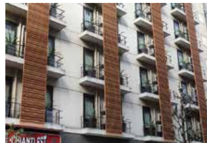
【6-④】 室外機の目隠しを壁面のアクセとし、植栽で側面から見えにくくした例
