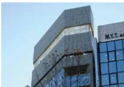
【6-②】 壁面と同じ材料を用いて、屋上設備を遮蔽した例
