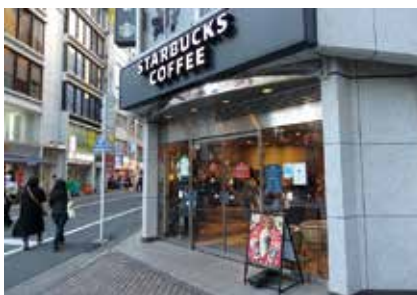
【1-①②】 店舗入口の舗装を歩道と段差がないように設えた例
