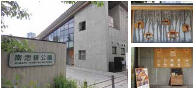
南池袋公園の施設に用いられた打放しコンクリートや木材などの素材色
