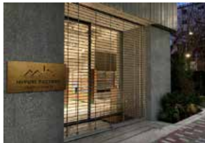
【3-①】 シースルーシャッターからの漏れ明かりが歩行者空間を照らした例（他都市）
