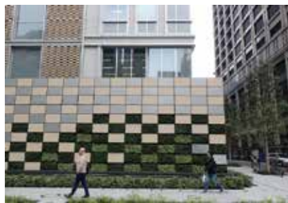
建築物と共通する意匠や色彩で設備類を修景した例（他都市）
