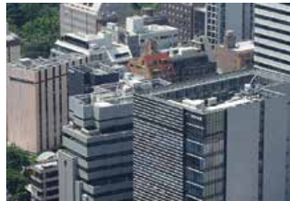
【6-②】 屋上の建物全周を遮蔽し、高層部からの見え方にも配慮した例（他都市）
