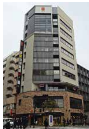
【14-①】 低層部や開口部を工夫して壁面を分節化した商業ビル（他都市）
