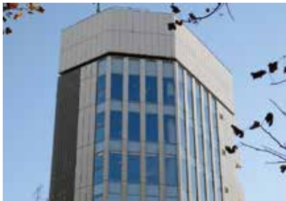
【8-①】 壁面と共通する材料と色彩で屋上の設備を修景した例
