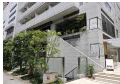
【9-①②】 オープンスペースに植栽を配置し、歩道に潤いを創出した例
