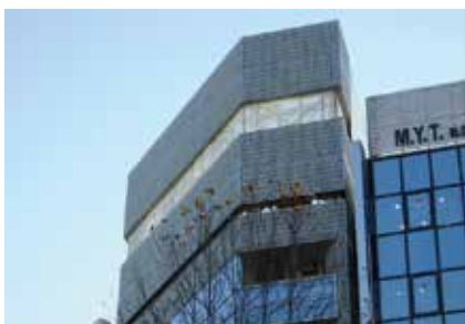
【8-①】 壁面と同じ材料を用いて、屋上設備を遮蔽した例
