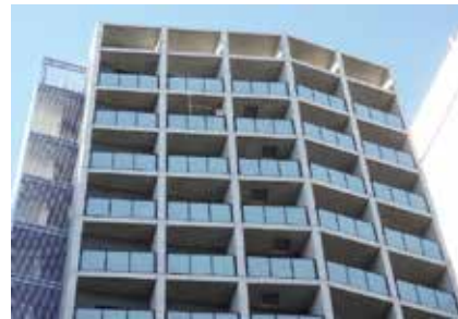
【9-①】 周辺からベランダ内部が見えないよう不透明なガラスを用いた例
