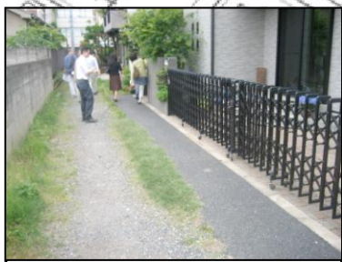
狭い道路を区工事で 拡張した場所。
