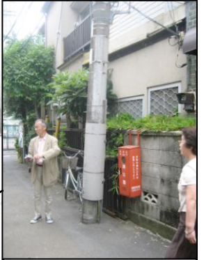
道路の幅を狭くして いる電柱(幅2.15m)。 斜めに立っている。
