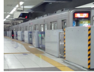
⑥ホームドアの設置状況
