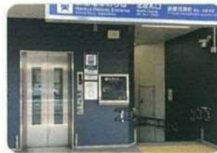
エレベーター (西院駅)
