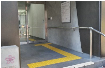
分庁舎出入口
