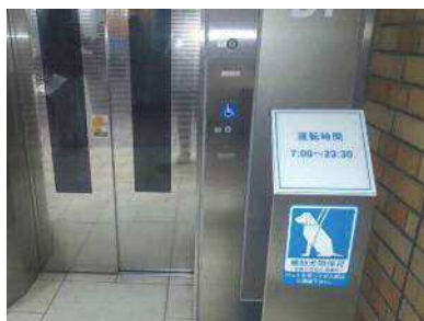
運転時間を示したエレベーター
