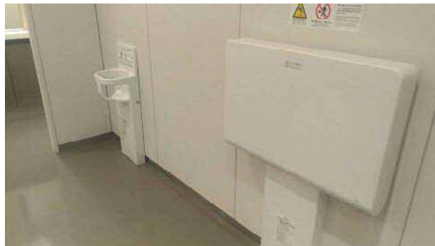
一般トイレ内への乳幼児用設備の設置
