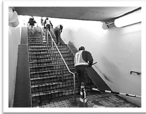
令和 4 年 1 月 5 日、6 日 ひばりがや地下道階段と踊り場に、滑り止め洗剤を塗布 (豊島区 都市整備部 道路整備課 道路工事事務所)
