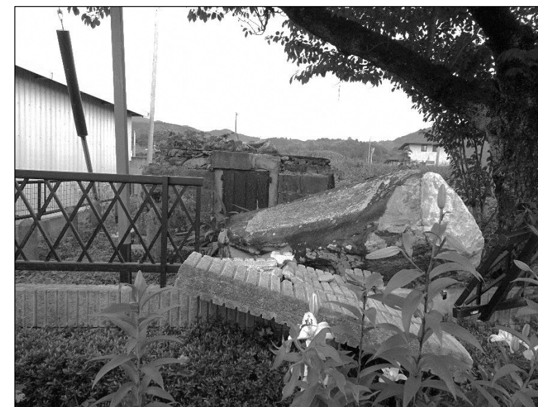
ブロック塀等の被害（熊本地震）
