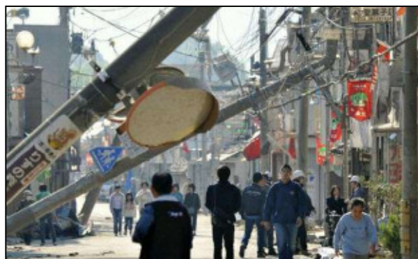
写真-4 電柱倒壊のイメージ
