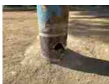
例5：亀裂やひび割れ
