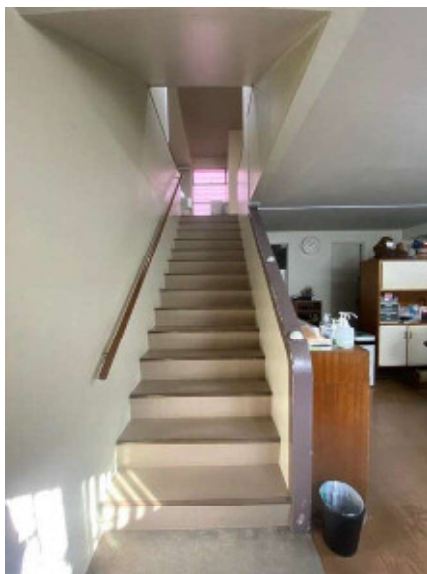
1階から2階の階段
