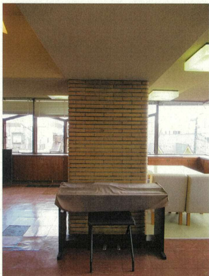
社屋内部⑧ 3階会議室 柱
