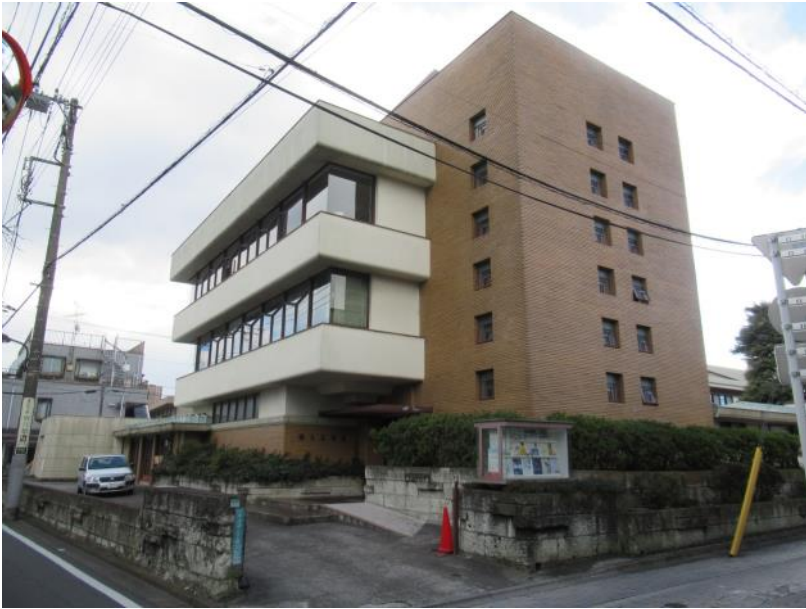
社屋外観① 北東側
