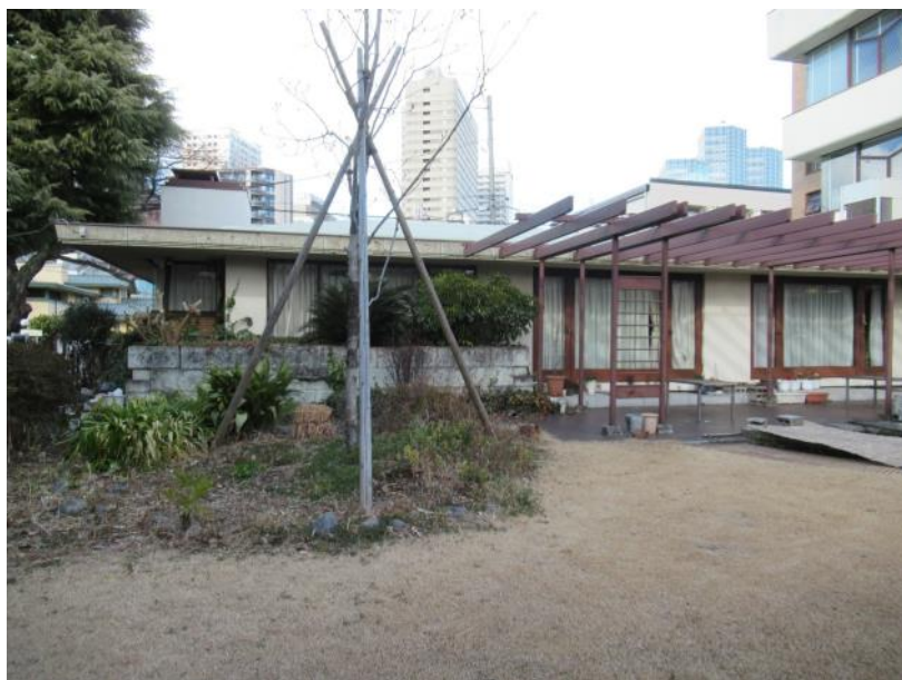
社屋外観④ 南側
