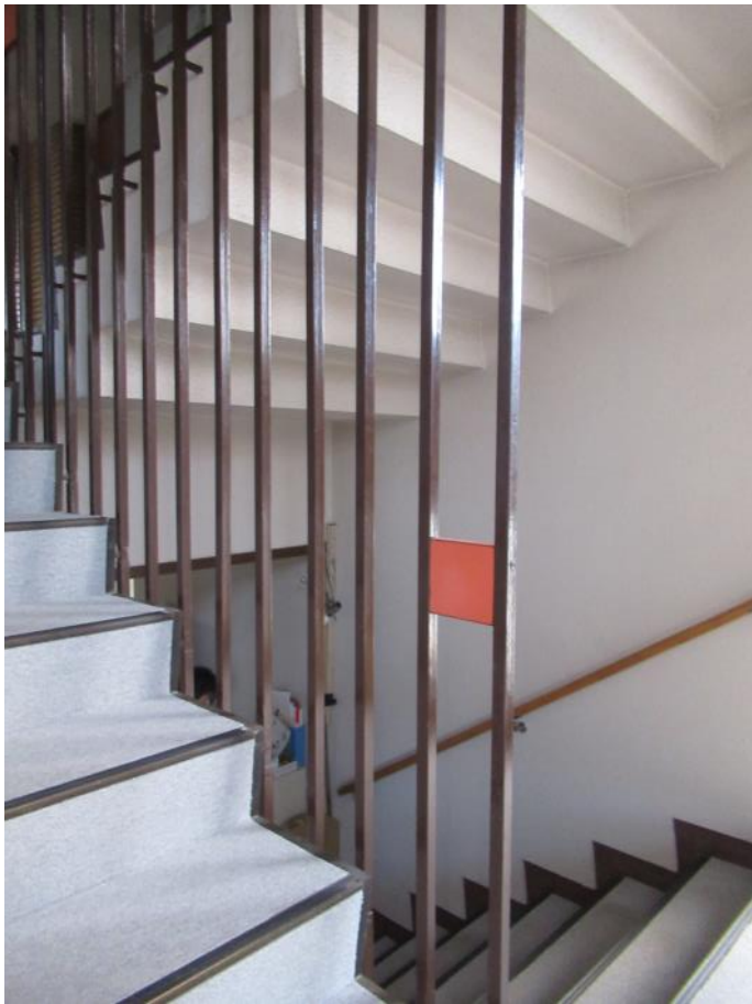
社屋内部⑥ 階段室
