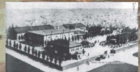
東洋乾板俯瞰図 1929(昭和4)年ごろ 出典：豊島区立郷土資料館 1994『町工場の履歴書』
