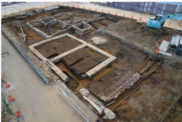
黄色の枠線部分を写した写真。手前からコンクリートでできた門の基礎、煉瓦敷の通路、コンクリートの基礎、1927（昭和2）年に建てられた研究所の煉瓦基礎。
