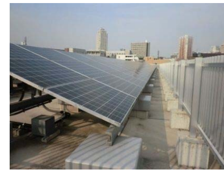
屋上の太陽光パネル
