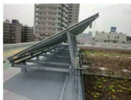
太陽光パネルと屋上緑化
