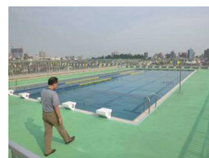
屋上プール （災害時防火水槽、マンホールトイレ排水）
