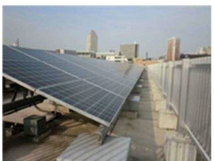
屋上の太陽光パネル（40kW）
