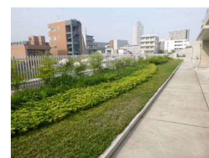
屋上緑化（3階部分）
