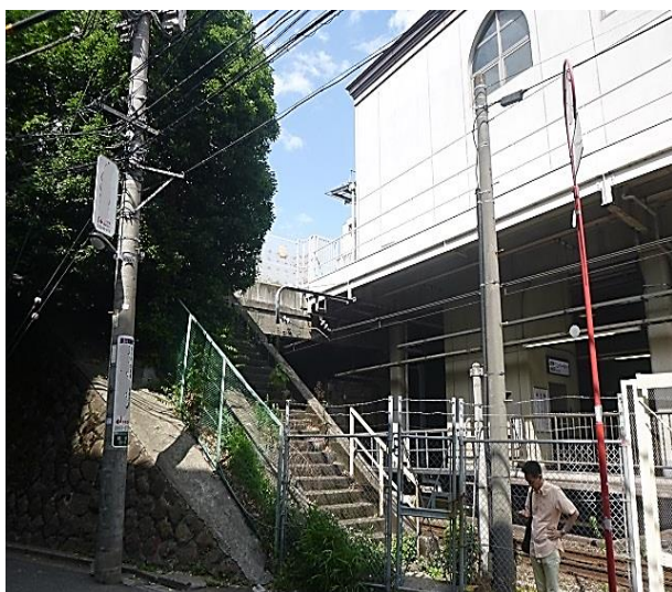
【1階 整備前の階段】
