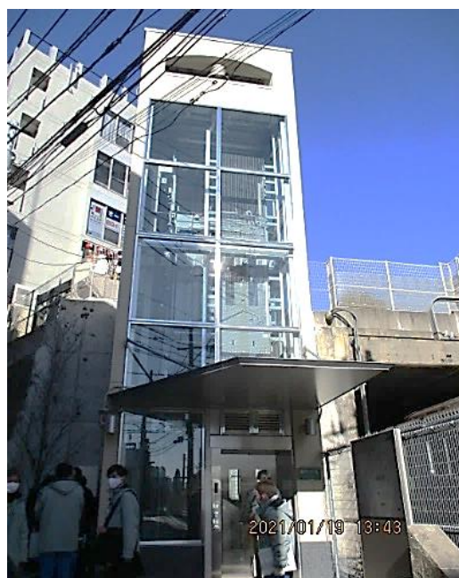
【1階 整備後の全景】
