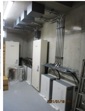
【発電した電気を蓄電する設備】
