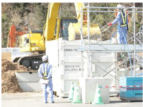
⑦ コンテナ積込作業
