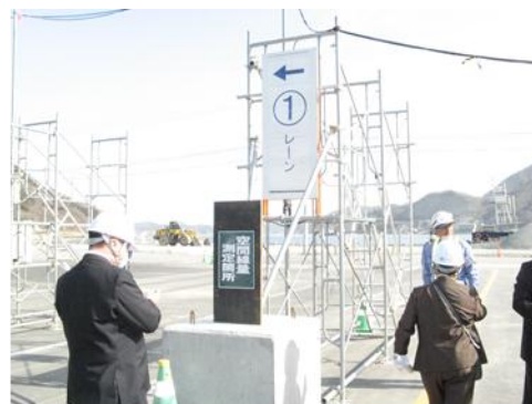
⑧ コンテナ積込後の空間線量率測定
