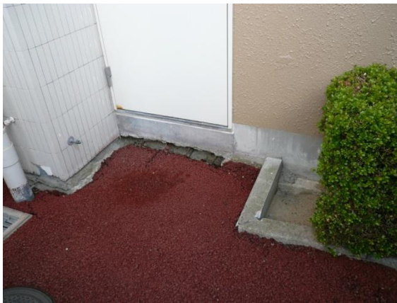
液状化によって段差ができています。
