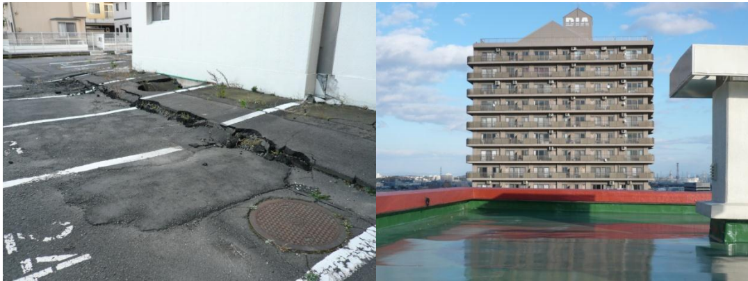
液状化により段差ができている。
