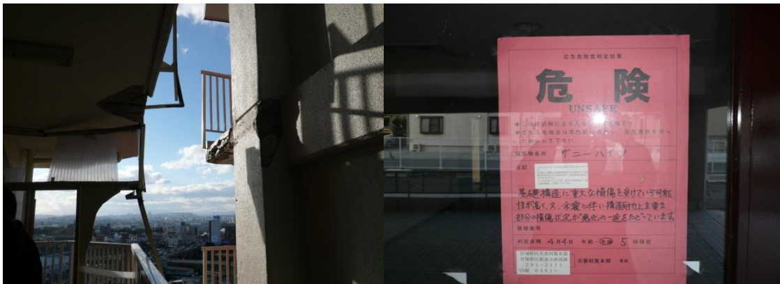
マンションの結合部分が外れてしまっている。
