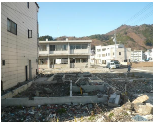
釜石市内の様子 土台だけを残した住宅
