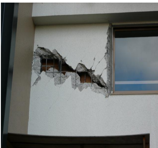
壁が破損し、中の鉄筋が見えている。
