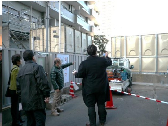
破損し、修理した受水槽の説明を受ける。
