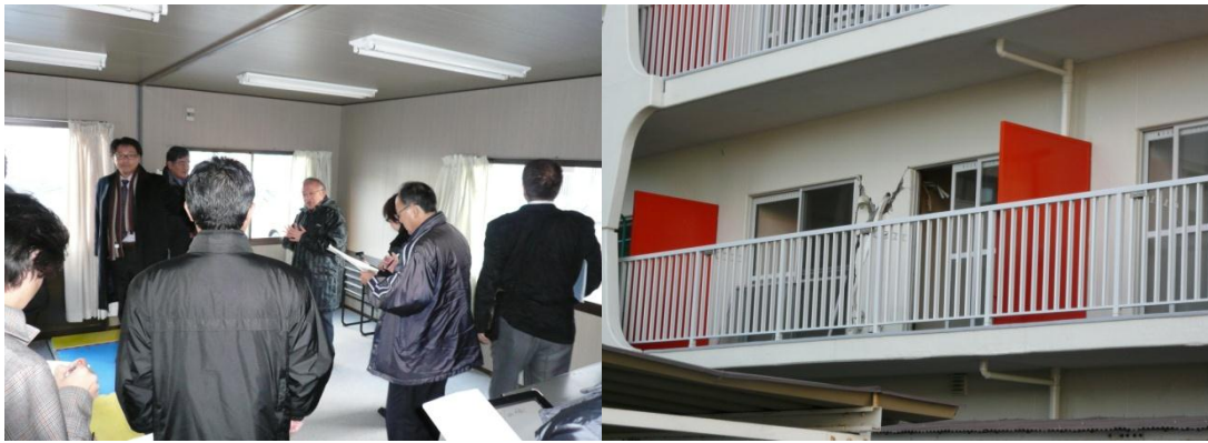
管理組合理事長伊藤氏より説明を受ける。 壁に入ったせん断亀裂
