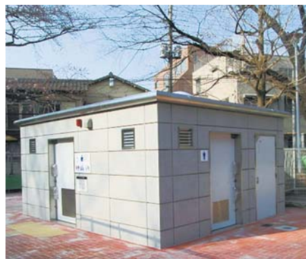
トイレの改修
