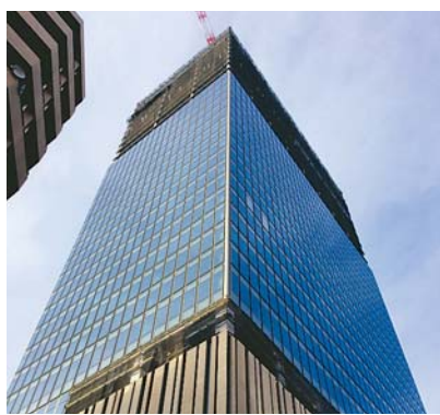
建設中のハレザ池袋
