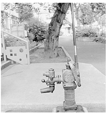
防災井戸(西巣鴨小学校)
