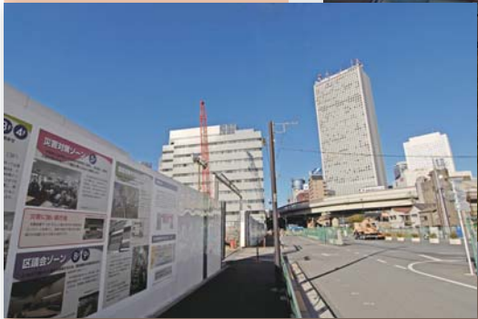
新庁舎建設地
