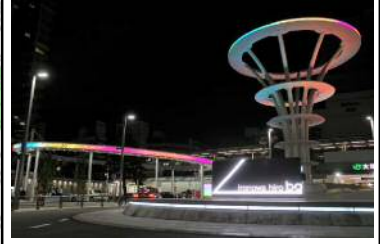
■大塚駅周辺整備(北口) (2021年3月)
