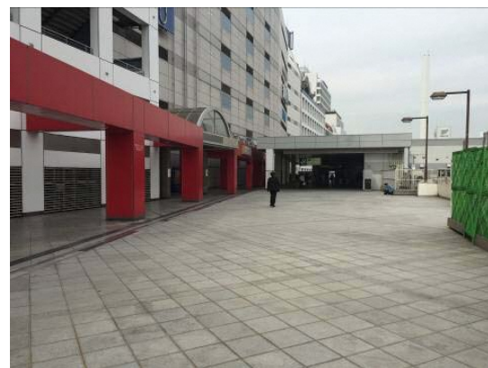
【メトロポリタンビルの既存デッキ】
