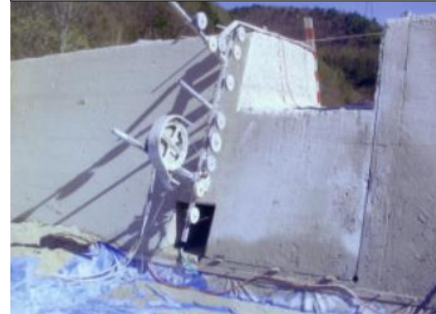
例)ワイヤーソー： コンクリート切断写真
