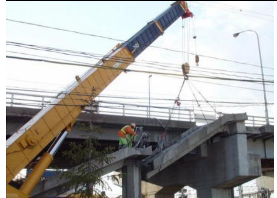
例) コンクリート撤去写真
