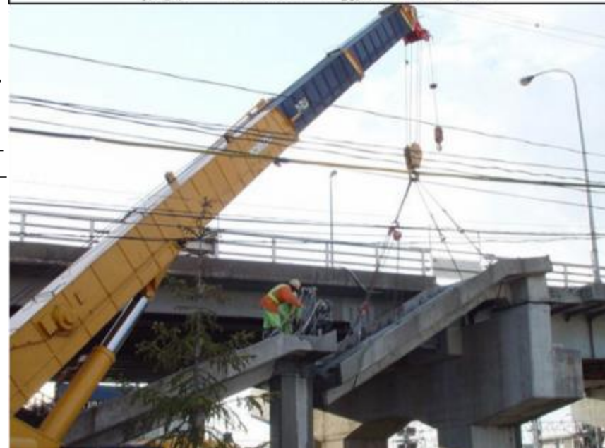
例) コンクリート撤去写真
