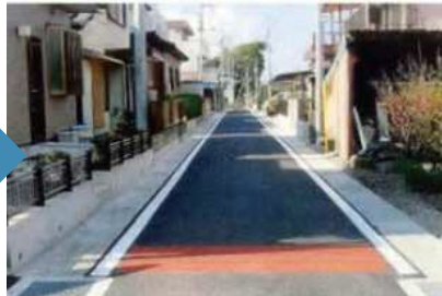
道路の拡幅と消防活動空間の確保
