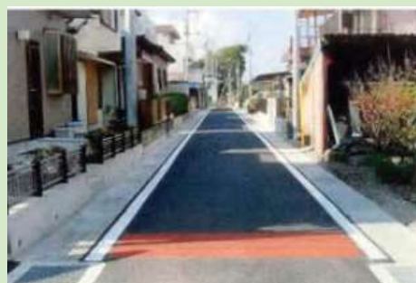
道路拡幅による消防活動空間の確保
