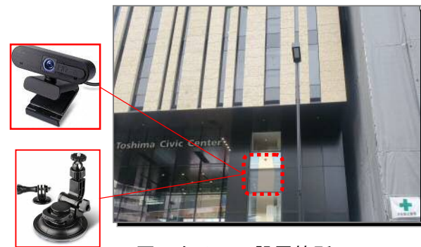
図 カメラの設置箇所
