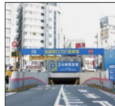
写真① 車高制限2.0mの 駐車場出入口
