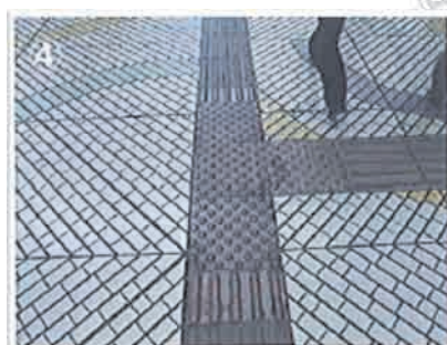
誘導ブロックの JIS 規格適合（西武地下通路）
