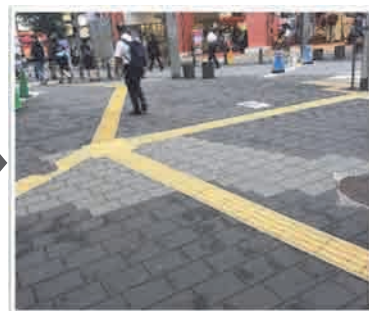
誘導ブロックの連続設置（サンシャイン 60 通り）
