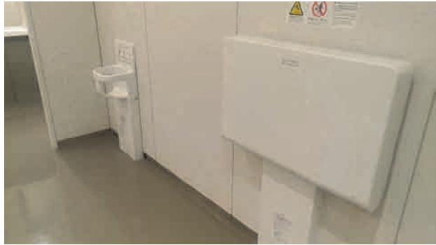
一般トイレ内への乳幼児用設備の設置
