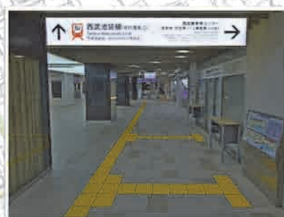
誘導ブロックの JIS 規格適合（西武地下通路）
