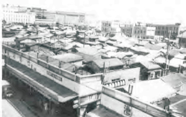
西口マーケットの様子（昭和35年撮影提供：豊島新聞社）写真左奥には東横百貨店（現在の東武百貨店）、中央奥には西武百貨店が見える。
