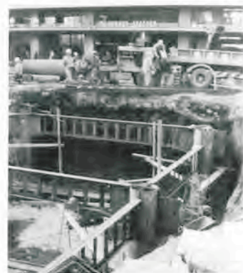
池袋東口の地下工事 昭和38年(1963年) 3月撮影 高木進一氏撮影・提供
