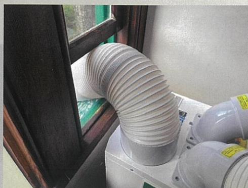
▲ダクトの設置方法も建物が傷つかないように工夫しています。
