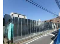
仮囲い鋼板(3m)
