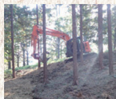
作業道開設の様子
