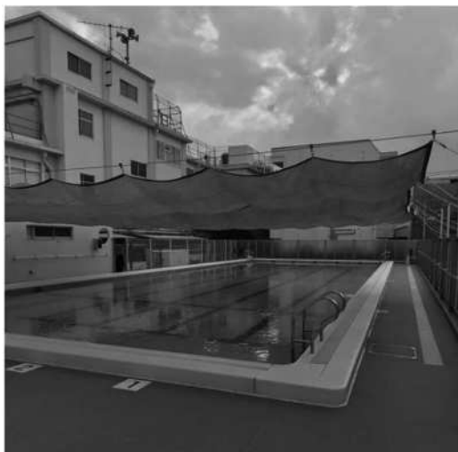
プール日除け設置事例 (長崎小)
