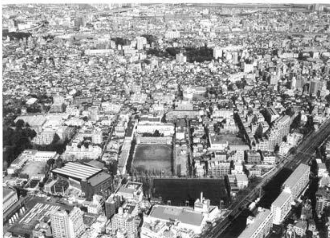
調査対象地区 遠景 南から
