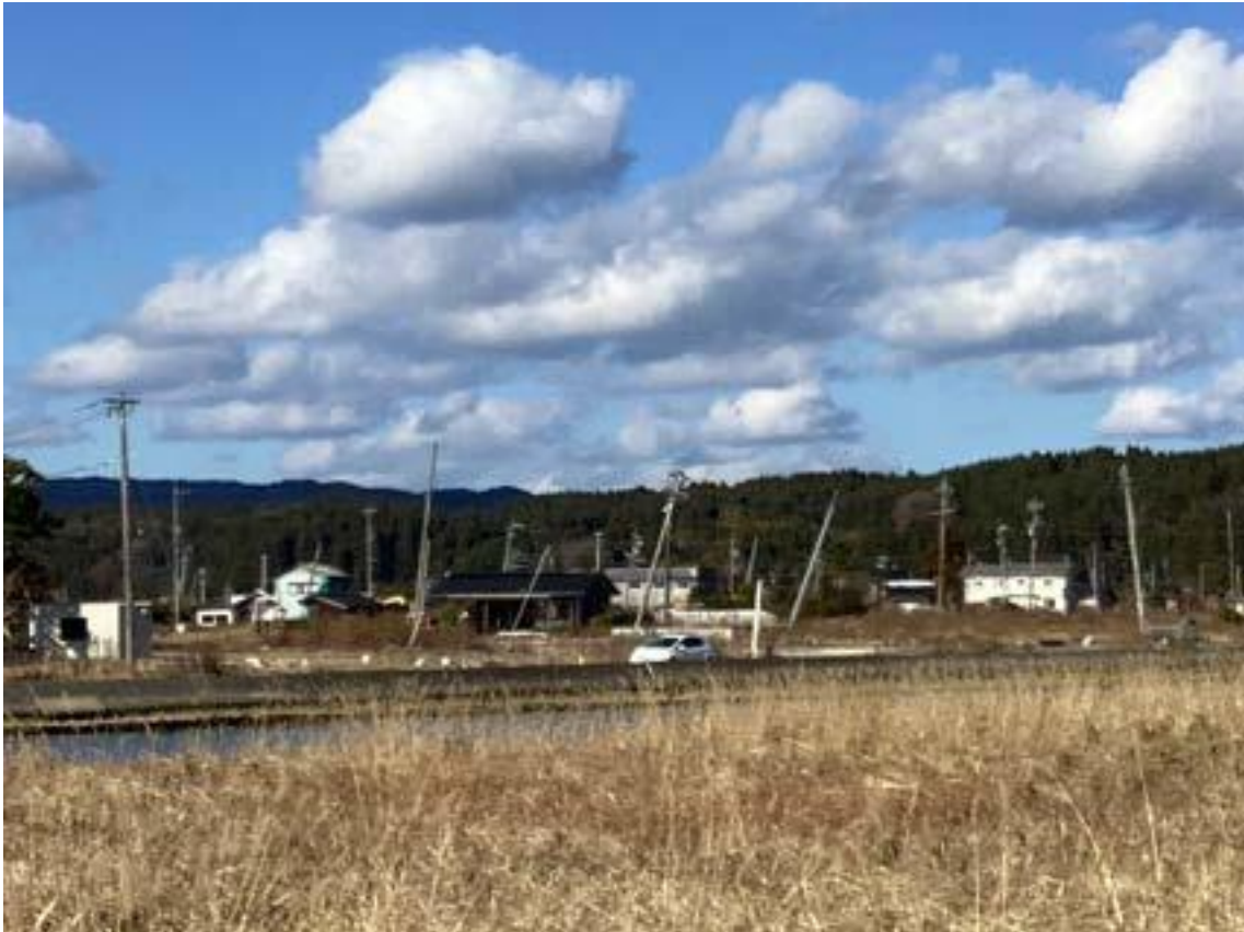
傾いたままの電柱
