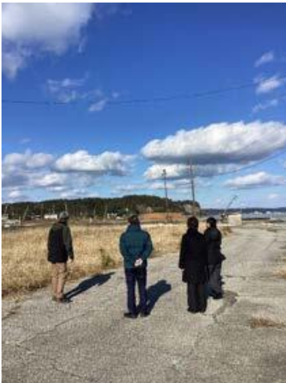
傾いたままの電柱及び道路の亀裂
