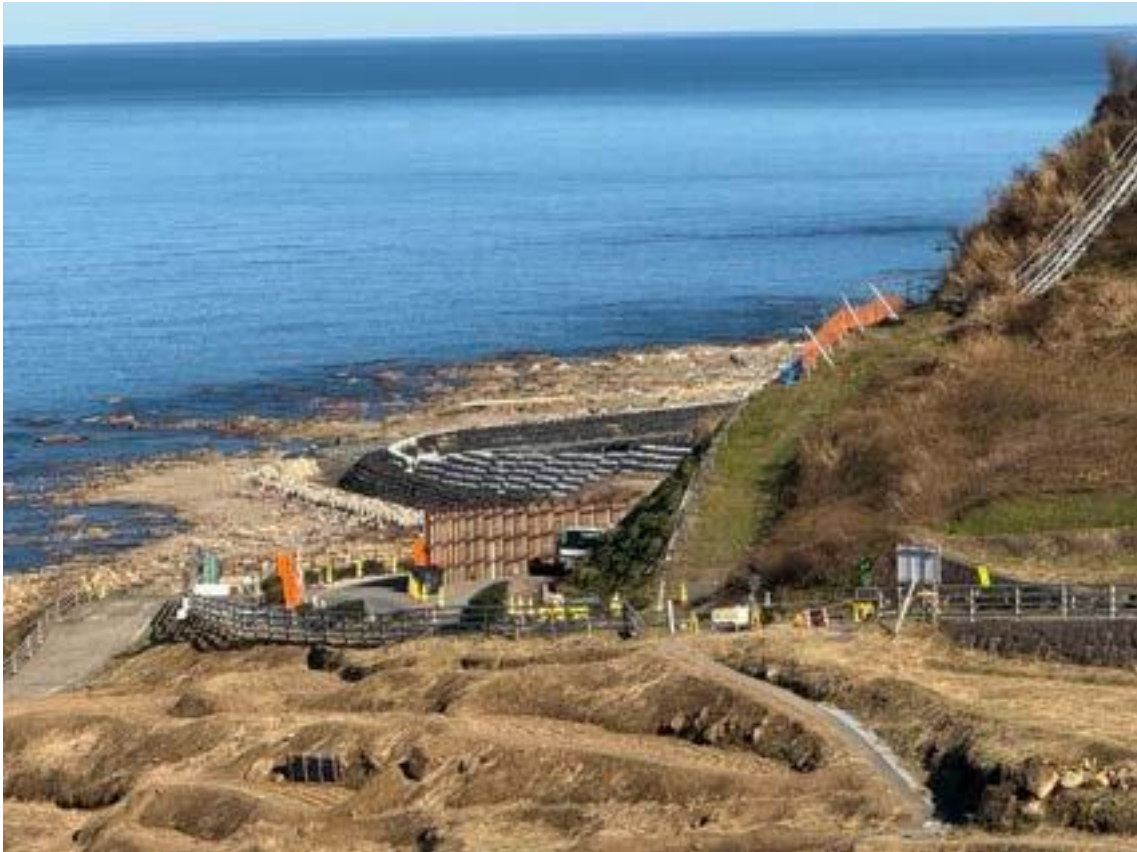
地震により海岸から隆起した陸地に道路整備が進められている
