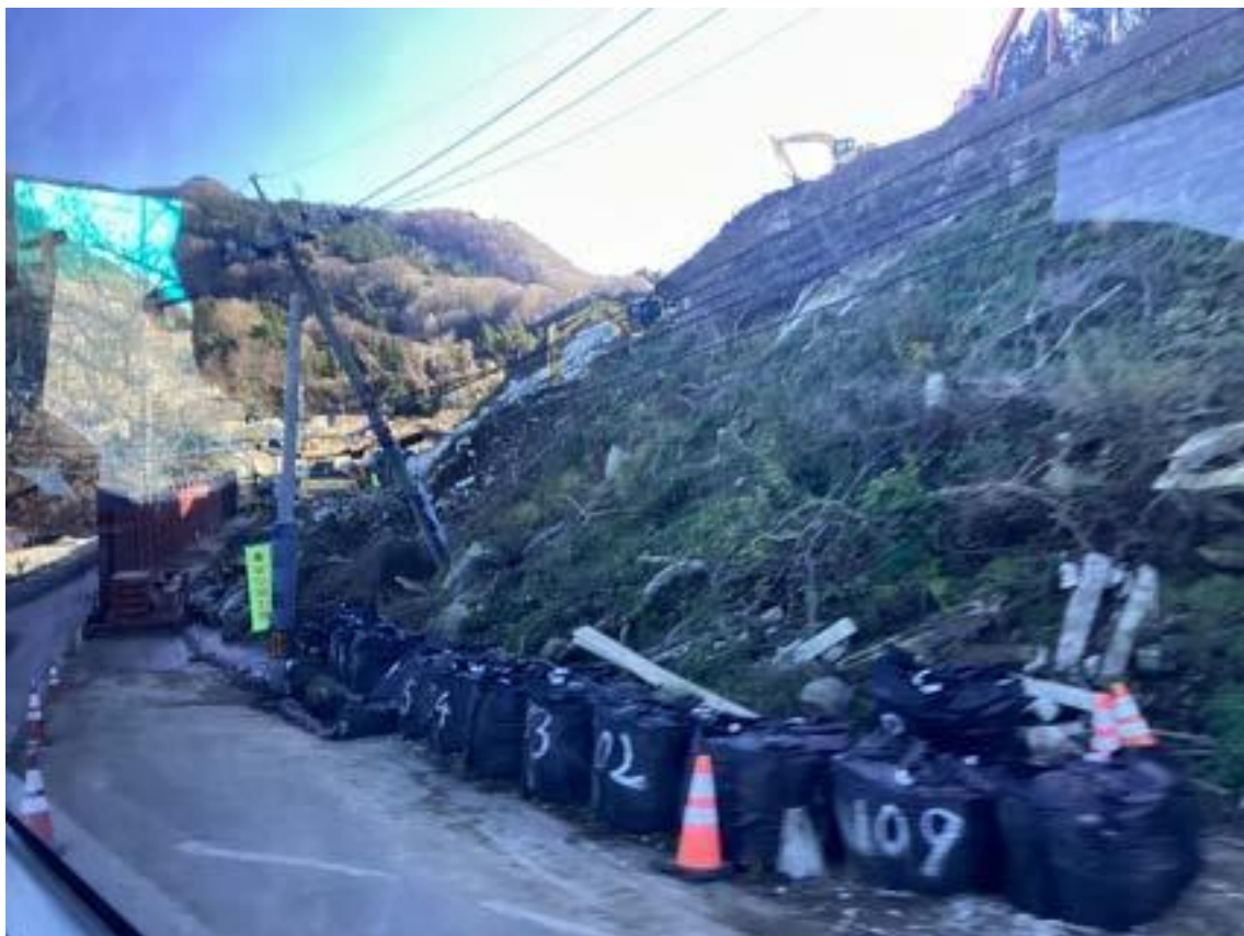
地震によるがけ崩れ
