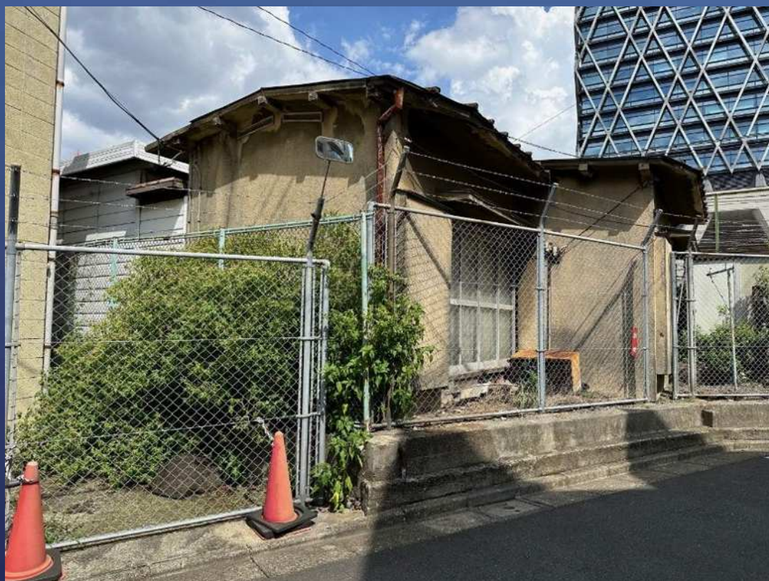
判定対象建築物：昭和39年築、木造、平屋
