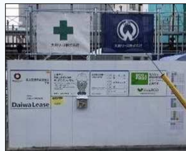
工事看板 イメージ
