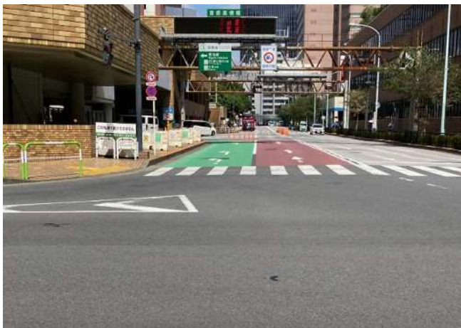
②首都高への誤進入に留意した整備が必要な区道
