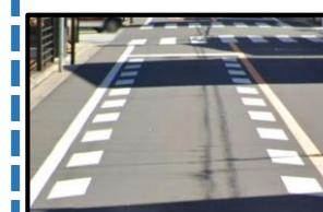
左図のように、車道内に速度抑制を促す破線を表示します。
