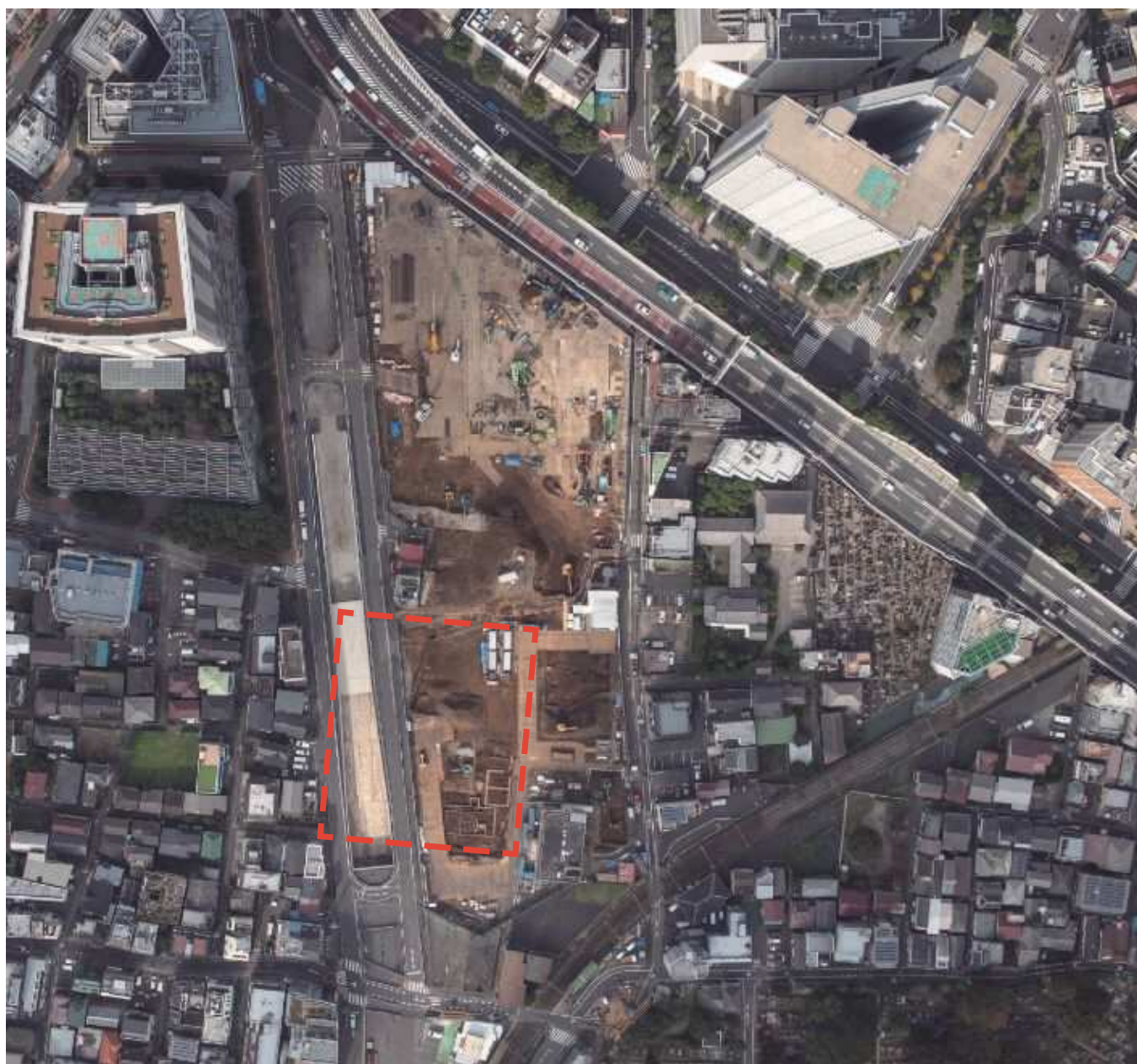
図3 調査時の空撮写真
